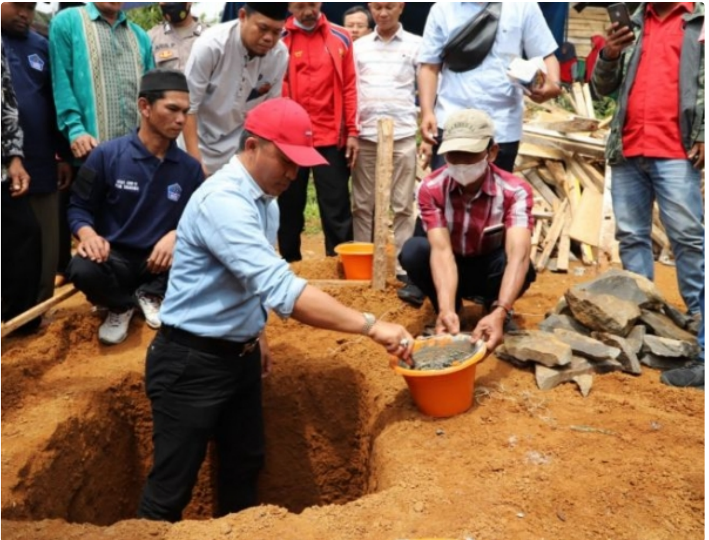
Peletakan batu pertama masjid at taqwa
